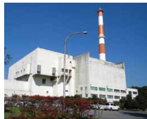
解体前の北谷津清掃工場
